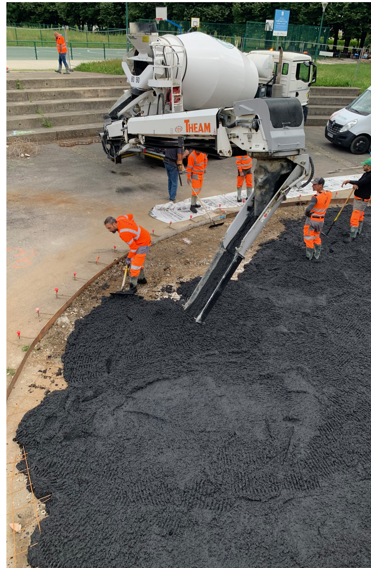
Préparation et coulage du béton recyclé Marbre d'ici lors de la réalisation de la scène centrale de la Place Rouge, 2025
