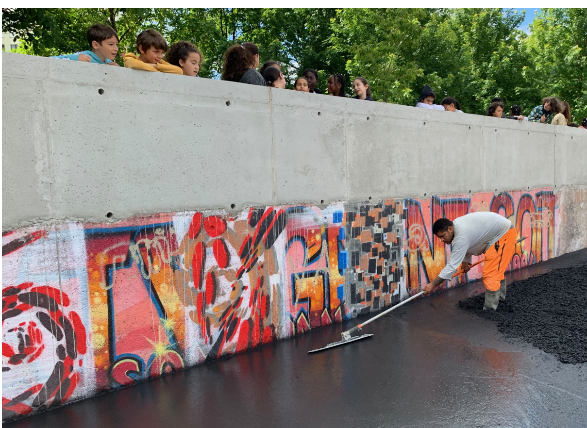
Préparation et coulage du béton recyclé Marbre d'ici lors de la réalisation de la scène centrale de la Place Rouge, 2025
