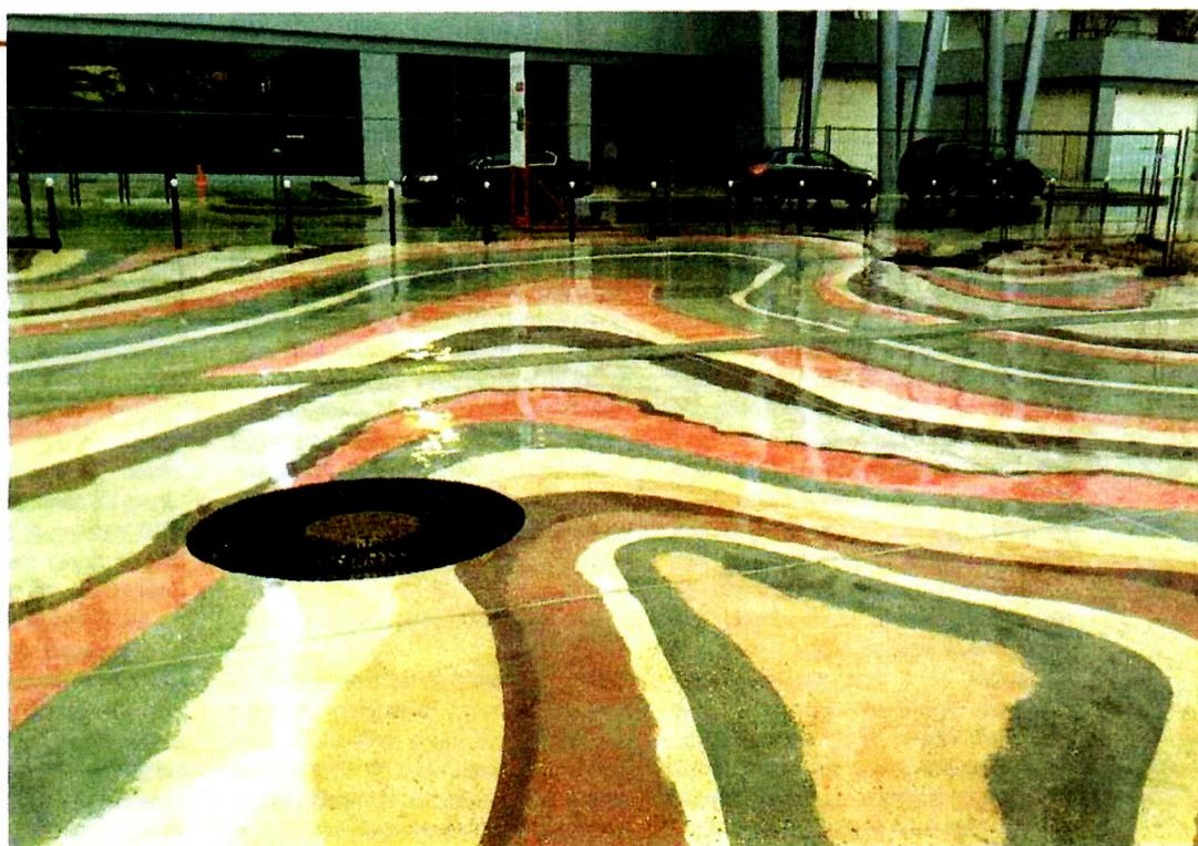
10 tonnes de tuiles, briques, parpaings et moellons calcaires ont été récupérées au sein de divers chantiers de démolition à Ivry-sur-Seine (Val-de-Marne). L'objectif : créer une dalle de 260 mètres carrés à mi-chemin entre l'œuvre d'art et l'espace public sur la place du Général-de-Gaulle.
