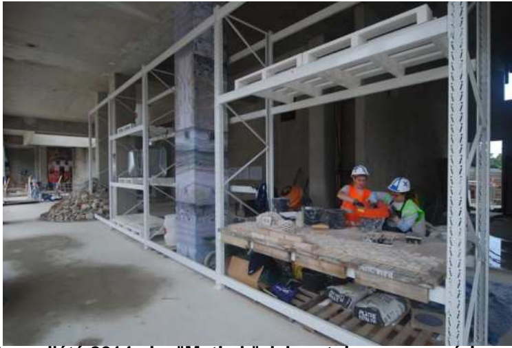
© SUPERPLACE – Plateau d'été 2014 - Le "MatLab", laboratoire pour expérimenter au coeur du chantier
