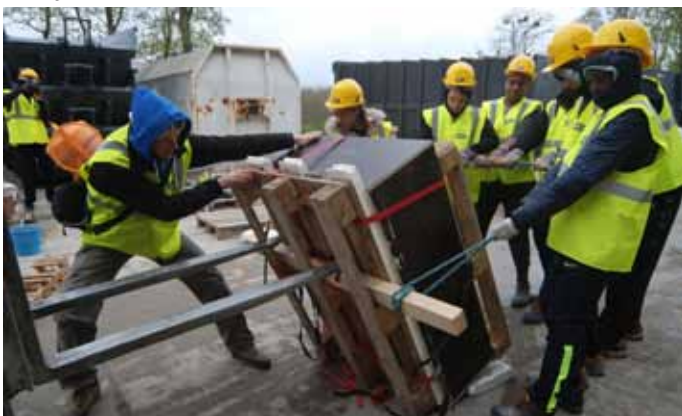
Retournement des blocs
